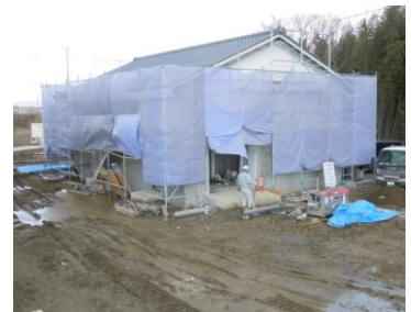
完成間近のコンポスト処理場
